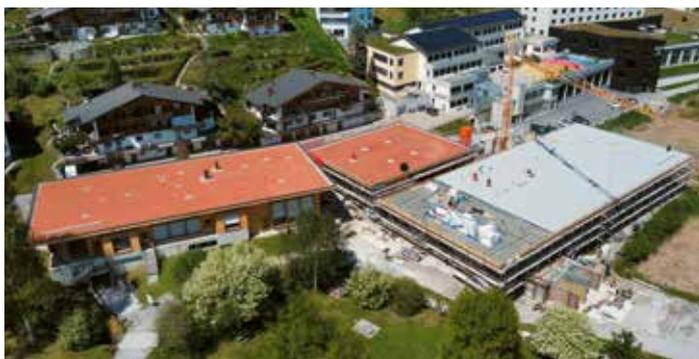
Auf dem Dach des neuen Schulgebäudes in Laax wurden auf einer Fläche von 2 900 m<sup>2</sup> Sarnafil® TG 66-18 Kunststoffdichtungsbahnen mit Randanschlüssen aus dem Sika-Dachsystem SikaRoof® AT verlegt. (Bild: Sika Schweiz AG)
