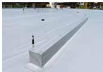
Stahlträger für die Stabilisierung der Dachkonstruktion des Vordaches (freihängend, ohne Stütze im unteren Bereich). Abgedichtet mit SikaRoof® AT-18 FSA P (Bild: Sika Schweiz AG)
